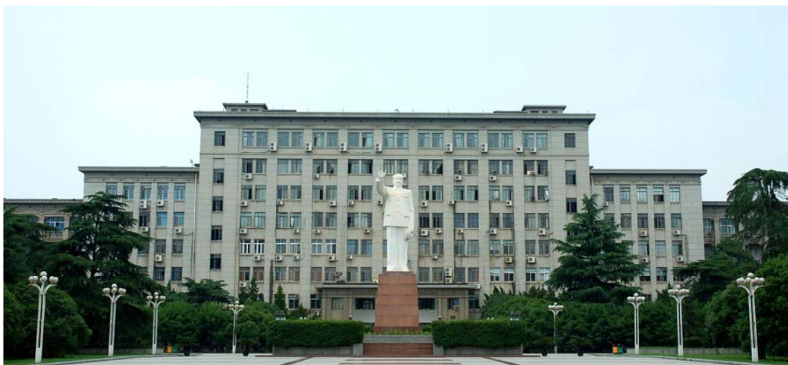
图片 1 位于学校中轴线上的南一楼
